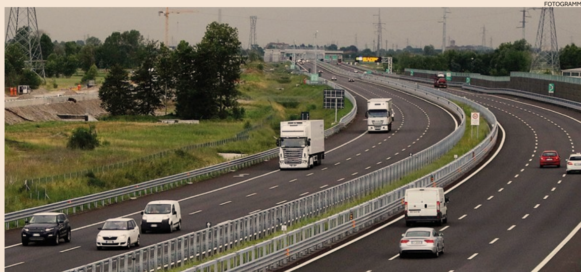
Brescia-Bergamo-Milano. L'autostrada è stata inaugurata il 23 luglio del 2014
